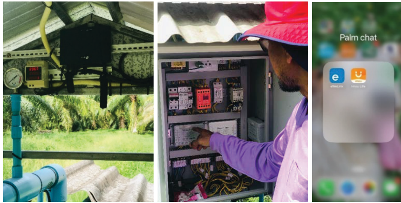
ภาพที่ 24 กล้องควบคุมระบบจ่ายน้ำอัตโนมัติ (IoT) ตามความต้องการน้ำของปาล์มน้ำมัน
