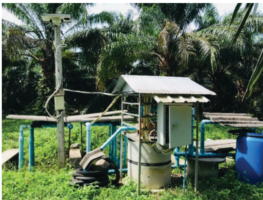
ภาพที่ 23 ระบบจ่ายน้ำอัตโนมัติ (IoT) ที่ใช้ในแปลงปาล์มน้ำมัน
