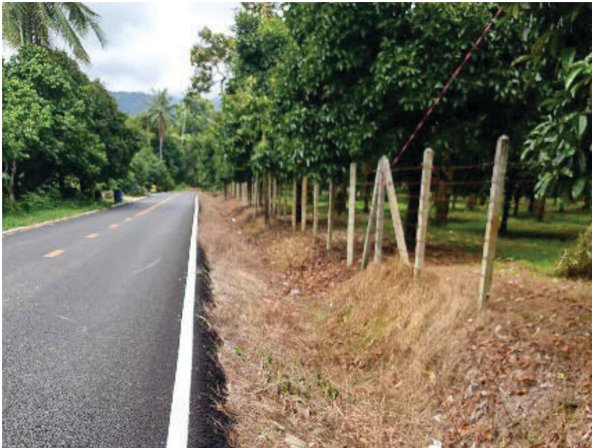
ภาพที่ 13 ลักษณะการขุดร่องระบายน้ำบริเวณรอบพื้นที่สวน
