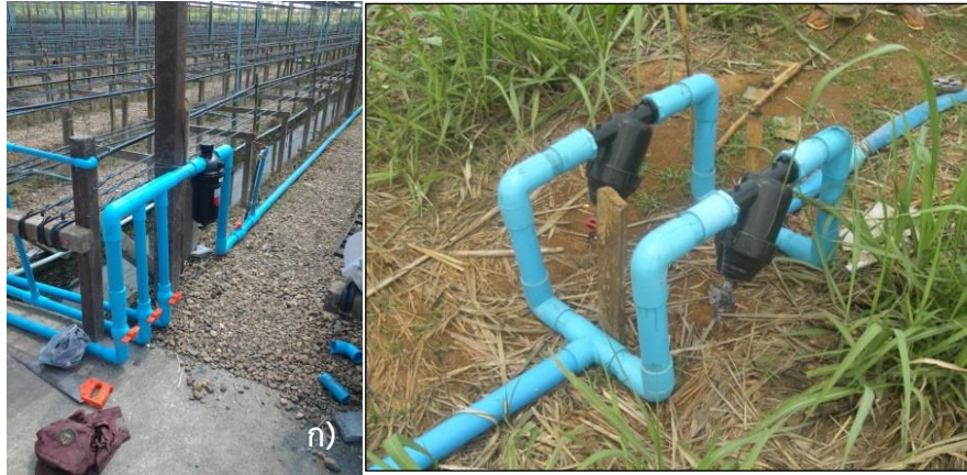
ภาพที่ 5.19 การต่อเครื่องกรองน้ำแบบเดี่ยว (ก) และแบบขนาน (ข)
