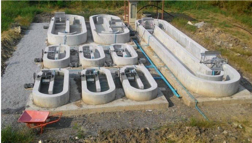
ภาพที่ 7 แสดงการติดตั้งระบบท่อระบายน้ำทั้ง ระบบเติมน้ำและอาหารเหลว
