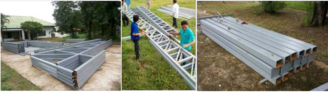
ภาพที่ 5 การเชื่อมประกอบโครงสร้างโรงเรือนเป็นชิ้นๆ ณ ศวศ.ขอนแก่น เพื่อเตรียมไปประกอบหน้างาน
