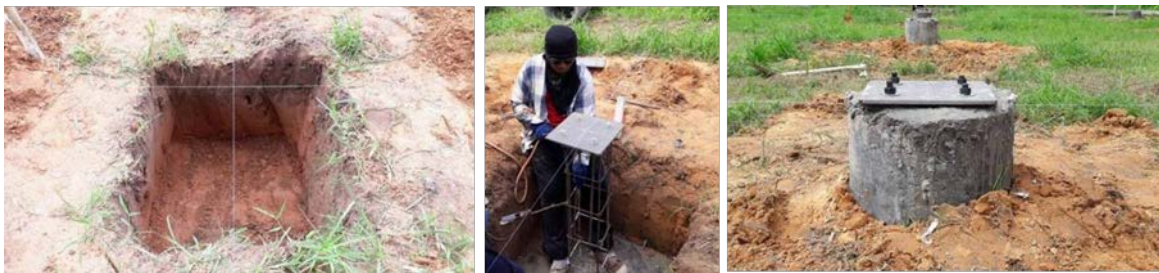
ภาพที่ 7 การทำตอม่อรับเสาโรงเรือน จำนวน 18 ต้น
