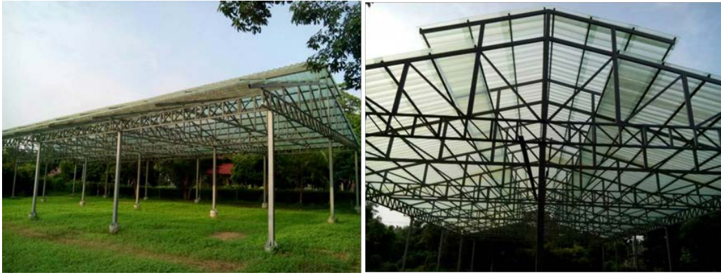
ภาพที่ 8 การประกอบติดตั้งชิ้นส่วนโครงสร้างโรงเรือนมุงหลังคาด้วยกระเบื้องใส
