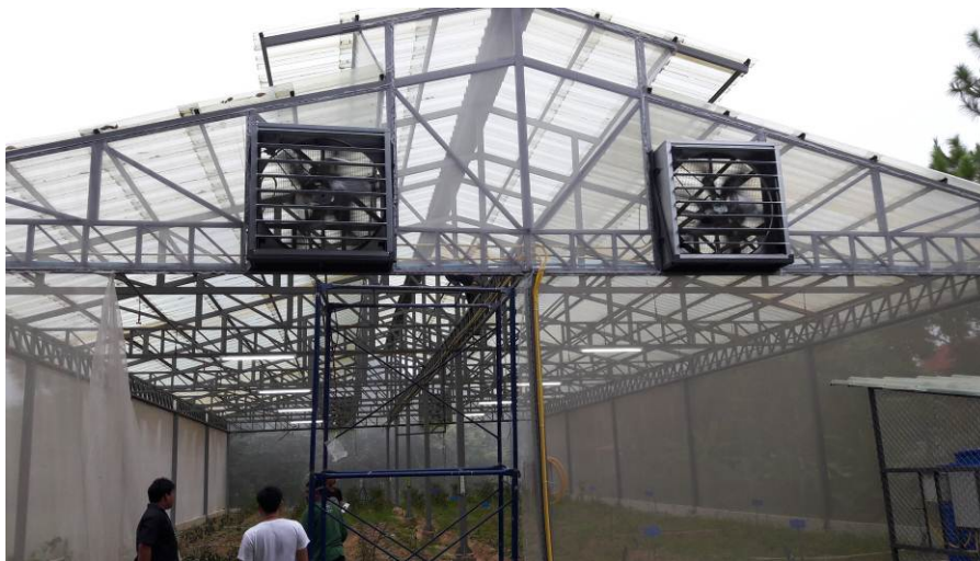
ภาพที่ 16 การติดตั้งพัดลมฟาร์มระบายอากาศในโรงเรือนปลูกพริก
