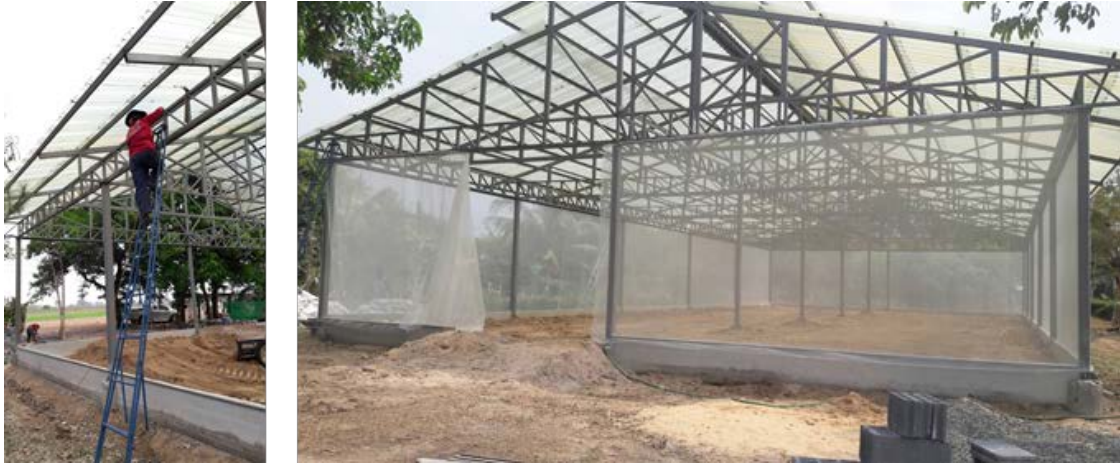
ภาพที่ 13 ทำการติดตั้งตาข่ายกันแมลงความถี่ 32 mesh โดยรอบโรงเรือนและส่วนที่เป็นช่องเปิด
