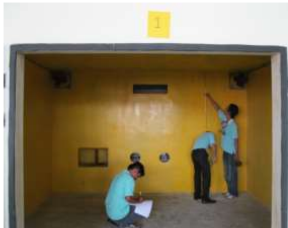
ภาพที่ 2 โรงรมแบบที่ 3 ใช้พัดลมช่วยในการกระจายตัวของซัลเฟอร์ไดออกไซด์
