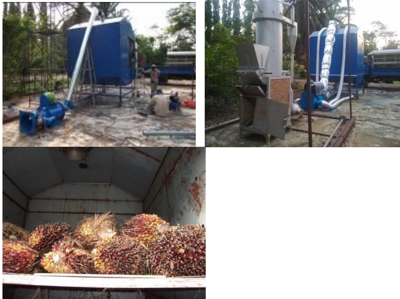
ภาพที่ 3.4.2 ประกอบชุดให้ความร้อนทะลายปาล์มน้ำมันระดับเชิงพาณิชย์ต้นแบบและสภาพภายในห้องให้ความร้อน
