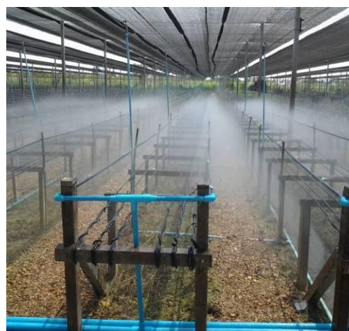
ง. ทดสอบระบบหลังการติดตั้ง
