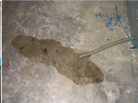
รูปที่ 10. ความชื้นในอากาศควบแน่นเป็นน้ำ
