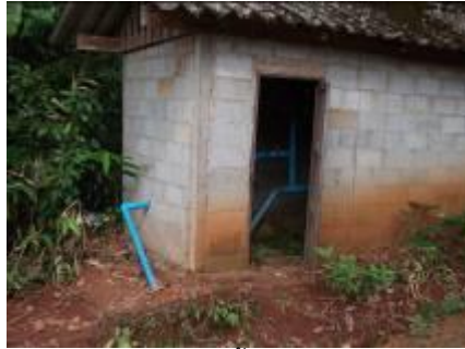
รูปที่ 10 ห้องจ่ายน้ำเข้าแปลงทดลอง
