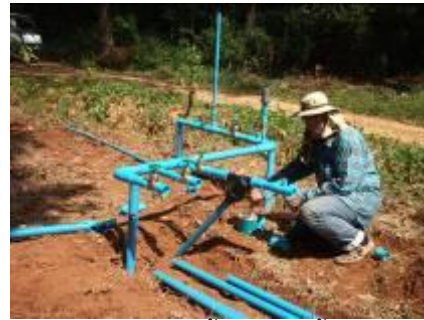
รูปที่ 11 ติดตั้งระบบให้น้ำ
