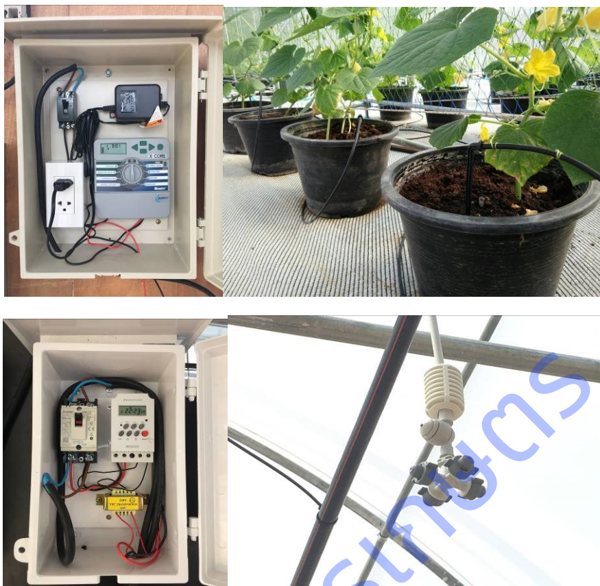
ภาพที่ 1.6 การติดตั้งระบบควบคุมการให้น้ำแบบหยด และระบบให้น้ำฟุ้งหมอก
