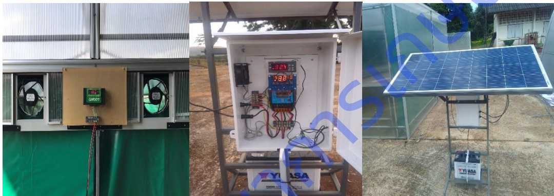
ภาพที่ 2.1.13 แสดงอุปกรณ์วัดอุณหภูมิภายในโรงตาก ที่เชื่อมต่อกับพัดลมดูดอากาศ และแผงโซลาร์เซลล์ที่ใช้ เป็นแหล่งพลังงานให้กับระบบอิเล็กทรอนิกส์ต่างๆที่ใช้กับโรงตาก เพื่อควบคุมอุณหภูมิภายในโรงตาก ไม่เกิน 42-45 องศาเซลเซียส
