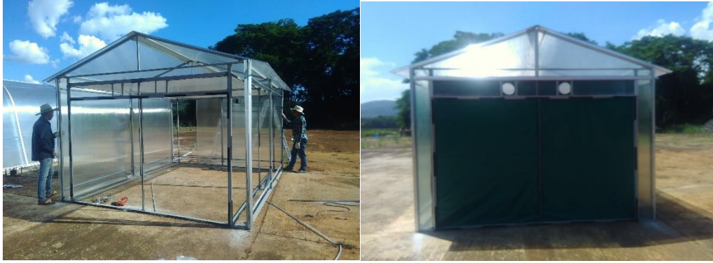
ภาพที่ 2.1.12 แสดงโรงตากทรงหลังคาหน้าจั่วที่ทำการปรับปรุงระบบ และประกอบโรงตากใหม่ เพื่อแก้ไข ปัญหาอุณหภูมิภายในโรงตากที่สูง ด้วยการเพิ่มฝาผนังภายในโรงตาก ชั้นที่ 2 เพื่อเกิดช่องว่างระหว่างผนัง สำหรับใช้ในการระบาย อากาศและการไหลเวียนอากาศร้อนภายในโรงตาก พร้อมกับติดตั้งพัดลมดูดอากาศ เพิ่มเติม
