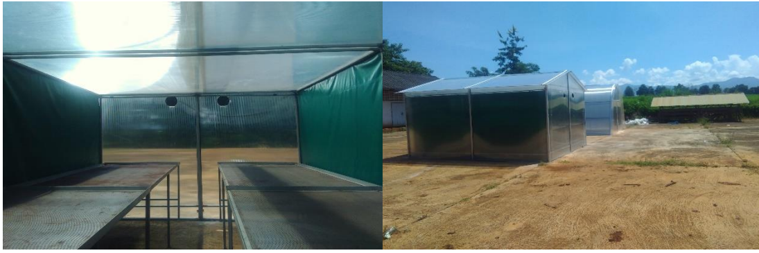
ภาพที่ 2.1.15 แสดงโครงสร้างภายในโรงตาก และ โรงตากทั้ง 2 แบบดำเนินการประกอบเรียบร้อยแล้ว
