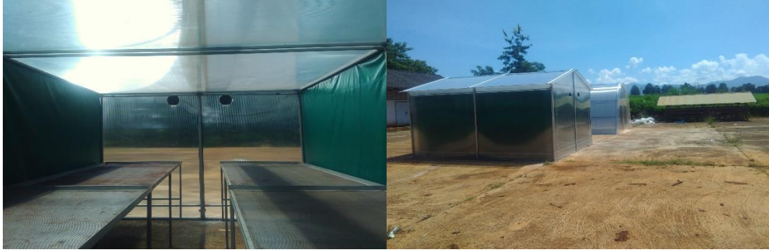
ภาพที่ 15 แสดงโครงสร้างภายในโรงตาก และ โรงตากทั้ง 2 แบบดำเนินการประกอบเรียบร้อยแล้ว
