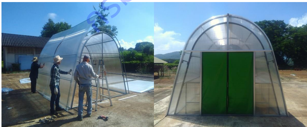
ภาพที่ 14 แสดงโรงตากทรงหลังคาโค้ง ที่ทำการประกอบพร้อมติดตั้งกับอุปกรณ์แผงโซลาร์เซลล์ อุปกรณ์เก็บพลังงานแสงอาทิตย์ที่จัดเตรียมไว้ใช้รวมทั้งเชื่อมต่อกับพัดลมดูดอากาศ และอุปกรณ์วัดอุณหภูมิภายในโรงตาก เพื่อใช้ทดสอบประสิทธิภาพการลดความชื้นเมล็ดพันธุ์ถั่วเหลืองในฤดูฝนนี้ต่อไป
