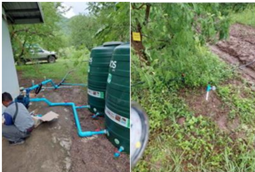
ภาพที่ 10 แสดงการติดตั้งระบบให้น้ำแบบสปริงเกอร์ และตัววัดความชื้นดิน Tensiometer
