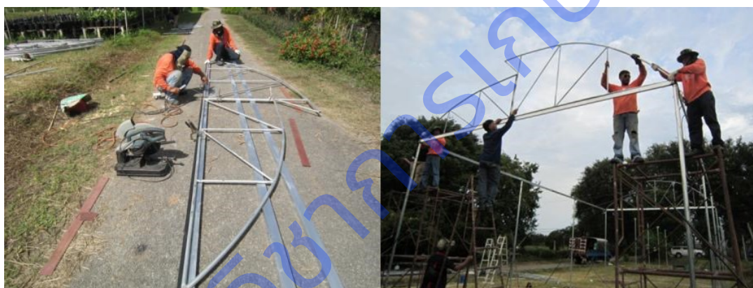
ภาพที่ 5 การประกอบโครงสร้างและติดตั้งหลังคาโรงเรียน
