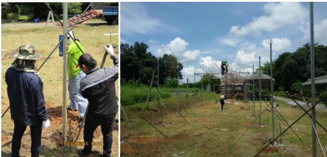
ภาพที่ 4 การตั้งเสา เเทคอนกรีตทับ และโครงสร้างหลักของโรงเรียน
