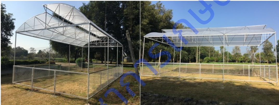
ภาพที่ 8 โรงเรือนหลังคาโค้งเหลี่ยมมุงพลาสติกขนาด 150 ไมครอน
