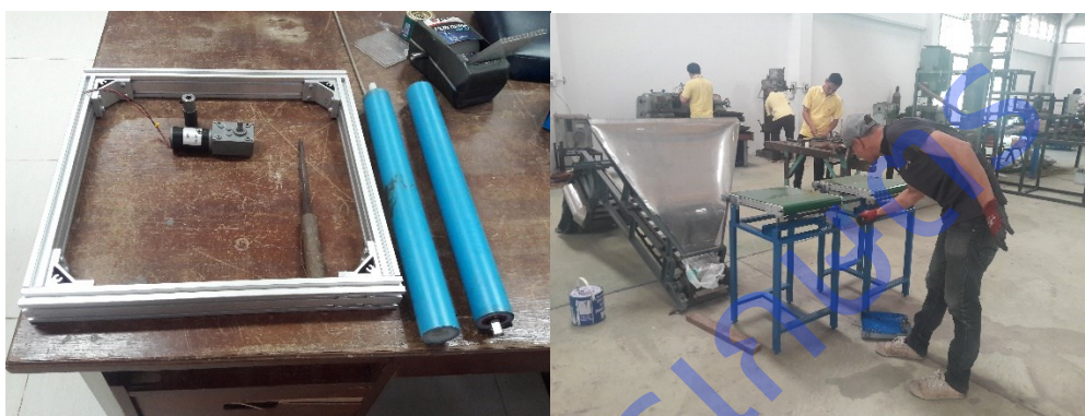
ภาพที่ 10 ติดตั้งอุปกรณ์มอเตอร์เกียร์และชุดสายพานลำเลียง PVC
