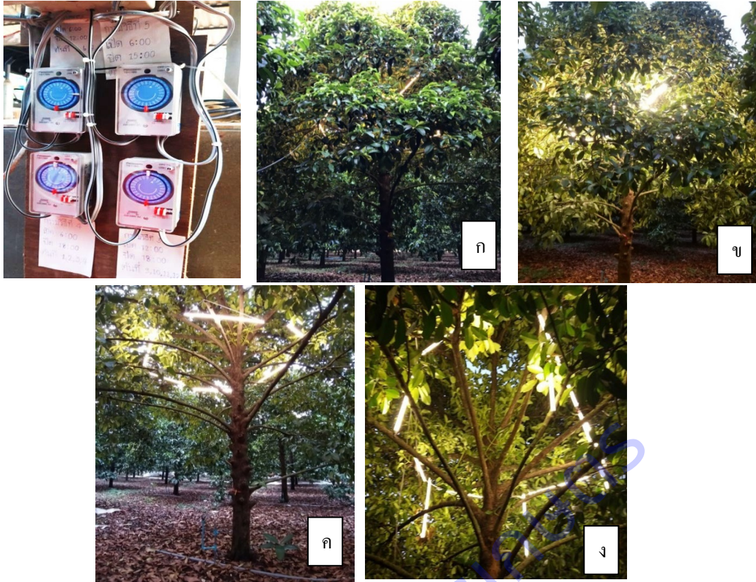
ภาพที่ 2.3.3 การติดตั้งหลอดไฟตามกรรมวิธีที่กำหนด ณ แปลงมังคุด ศูนย์วิจัยพืชสวนจันทบุรี
