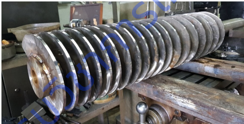
ภาพที่ 37 เชื่อมใบสกรูกับแกนเพื่อเป็นสกรูอัดแบบ Variable pitch screw
