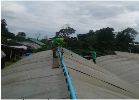
(จ) ติดตั้งระบบน้ำบนหลังคาโรงเรือน ณ ศวพ.ชม.
