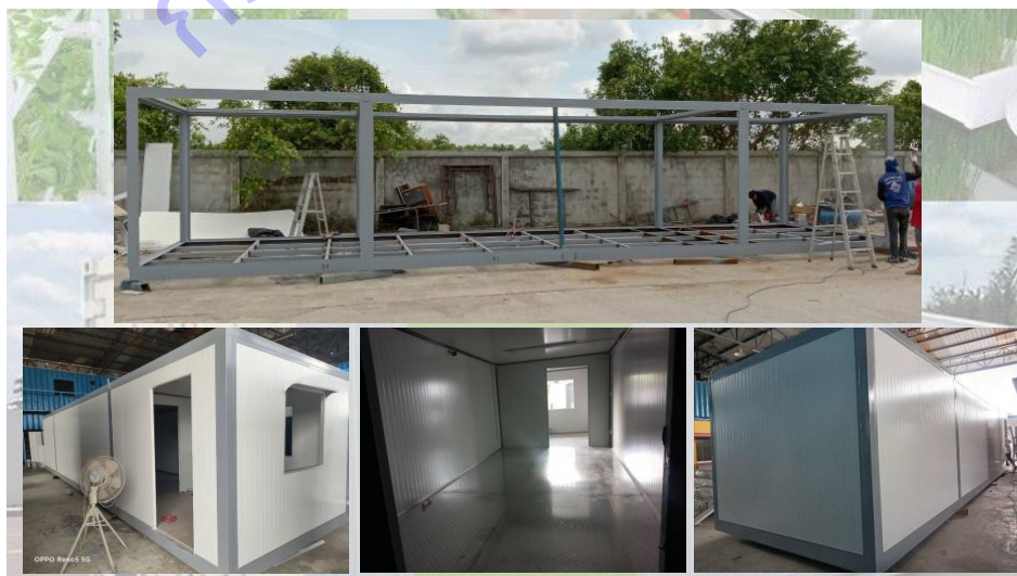
ภาพที่ 1.4 ลักษณะโครงสร้างโรงเรือนปลูกพืชแบบตู้คอนเทนเนอร์
