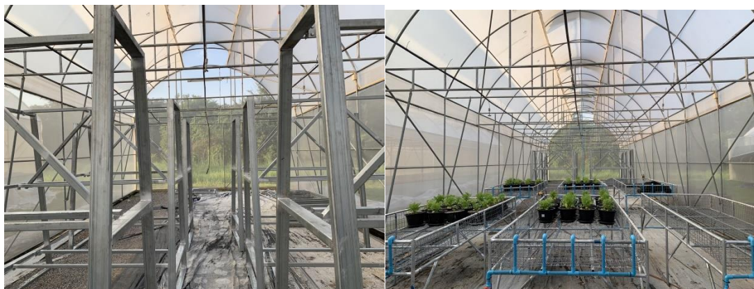
ภาพที่ 5.3 การสร้างโต๊ะปลูกและชุดปลูกพืชแนวตั้งจำนวนอย่างละ 6 ตัว
