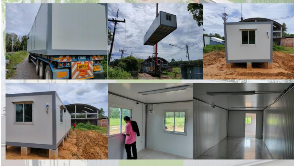
ภาพที่ 1.5 ลักษณะตู้คอนเทนเนอร์สำหรับใช้เป็นต้นแบบโรงงานผลิตพืชขนาด 3*12 เมตร
