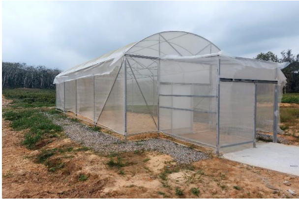
ภาพที่ 4.5 ต้นแบบโรงเรือนสำหรับทดสอบระบบการควบคุมสภาพอากาศและความชื้นสัมพัทธ์เบื้องต้น
