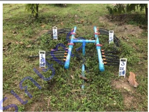
ภาพที่ 4 การติดตั้งระบบน้ำเสร็จ พร้อมใช้
