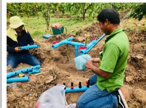
ภาพที่ 3 การเตรียมอุปกรณ์ติดตั้งระบบน้ำ
