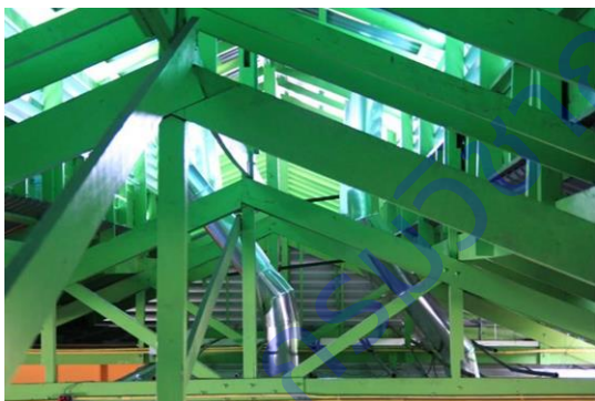
ภาพที่ 12 ลักษณะการติดตั้งท่อนำแสงในอาคารที่มีหลังคาและฝ้าเพดาน
