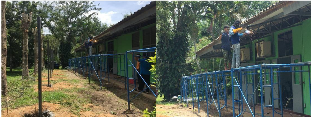
ภาพที่ 18 การดำเนินการจัดสร้างอาคารทดลองระบบท่อนำแสง ณ ศวศ.สุราษฎร์ธานี
