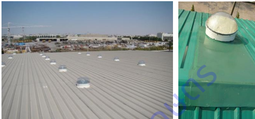
ภาพที่ 14 ภาพการติดตั้งท่อนำแสงบนพื้นผิวหลังคาเหล็ก
