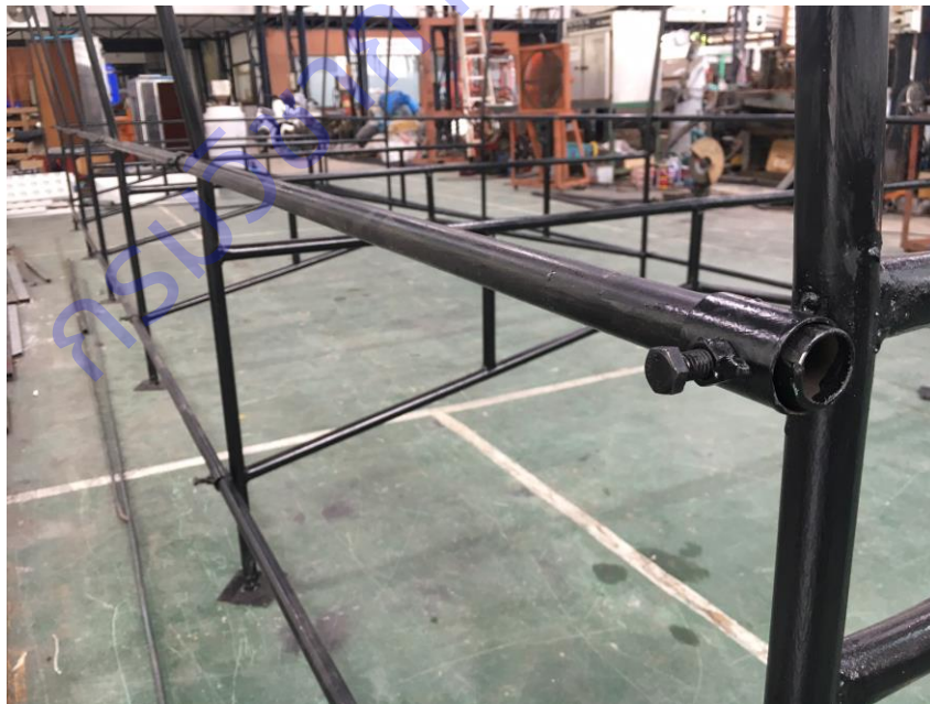
ภาพที่ 8 ท่อเหล็กยึดโครงสร้างโรงเรือนแต่ละชุดให้เป็นโรงเรือน
