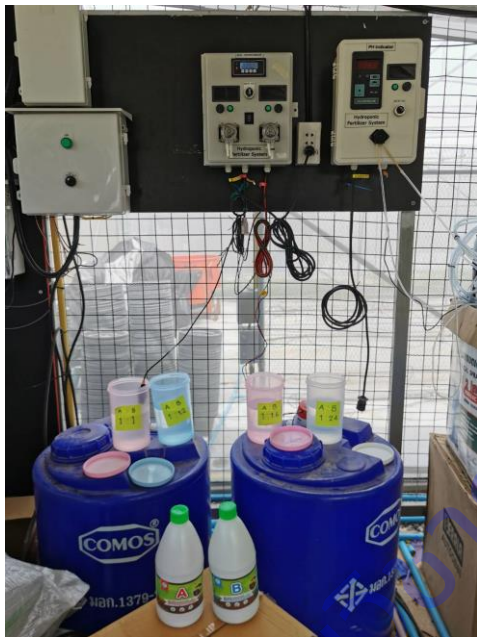
ภาพที่ 8 ทดสอบระบบการให้ปุ๋ยพร้อมระบบน้ำหยด
