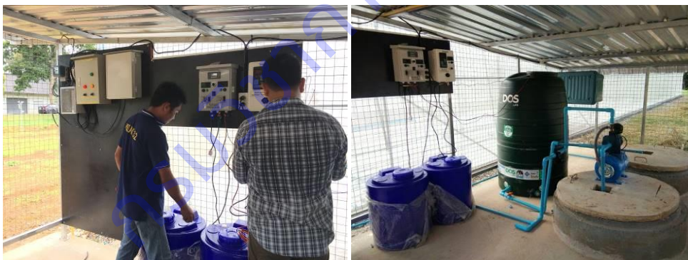
ภาพที่ 2 ติดตั้งชุดทดสอบการควบคุมระบบจ่ายปุ๋ยแบบอัตโนมัติ
