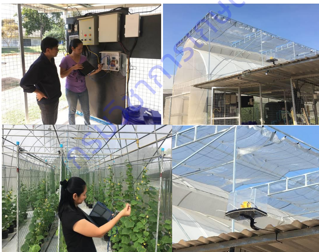
ภาพที่ 8 การติดตั้งระบบควบคุมม่านพรางแสงแบบอัตโนมัติส่วนบนหลังคาโรงเรือน
