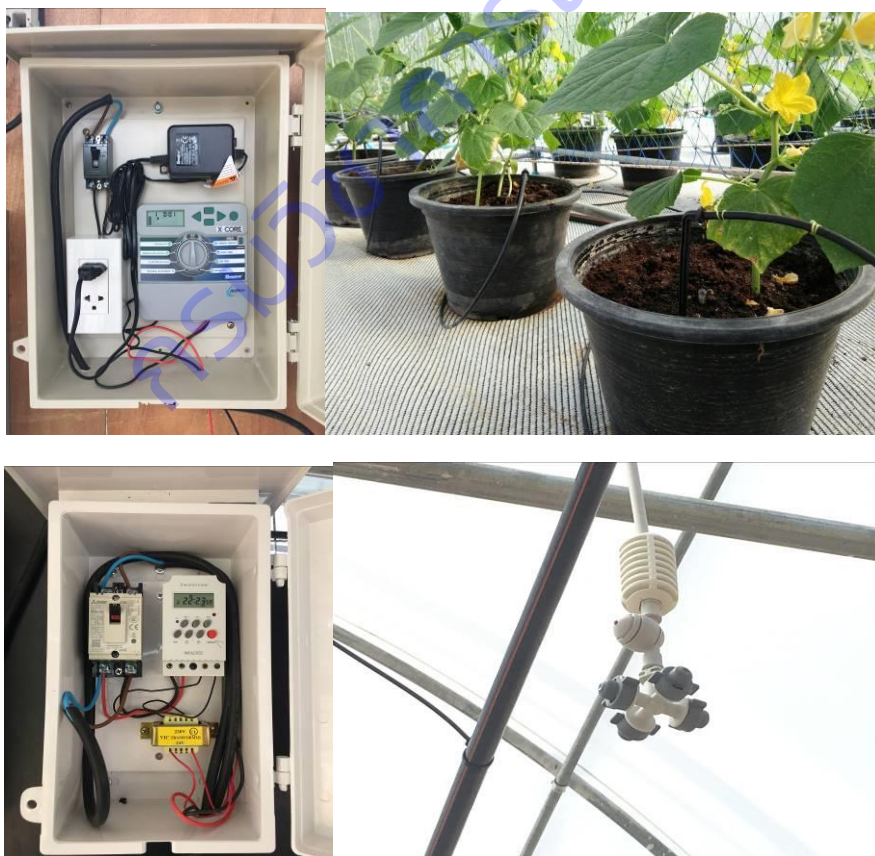
ภาพที่ 6 การติดตั้งระบบควบคุมการให้น้ำแบบหยด และระบบให้น้ำพ่นหมอก
