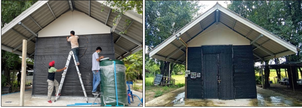
ภาพที่ 1 การก่อสร้างโรงเรือนเห็ดและติดตั้งระบบ Evaporative Cooling Systems
