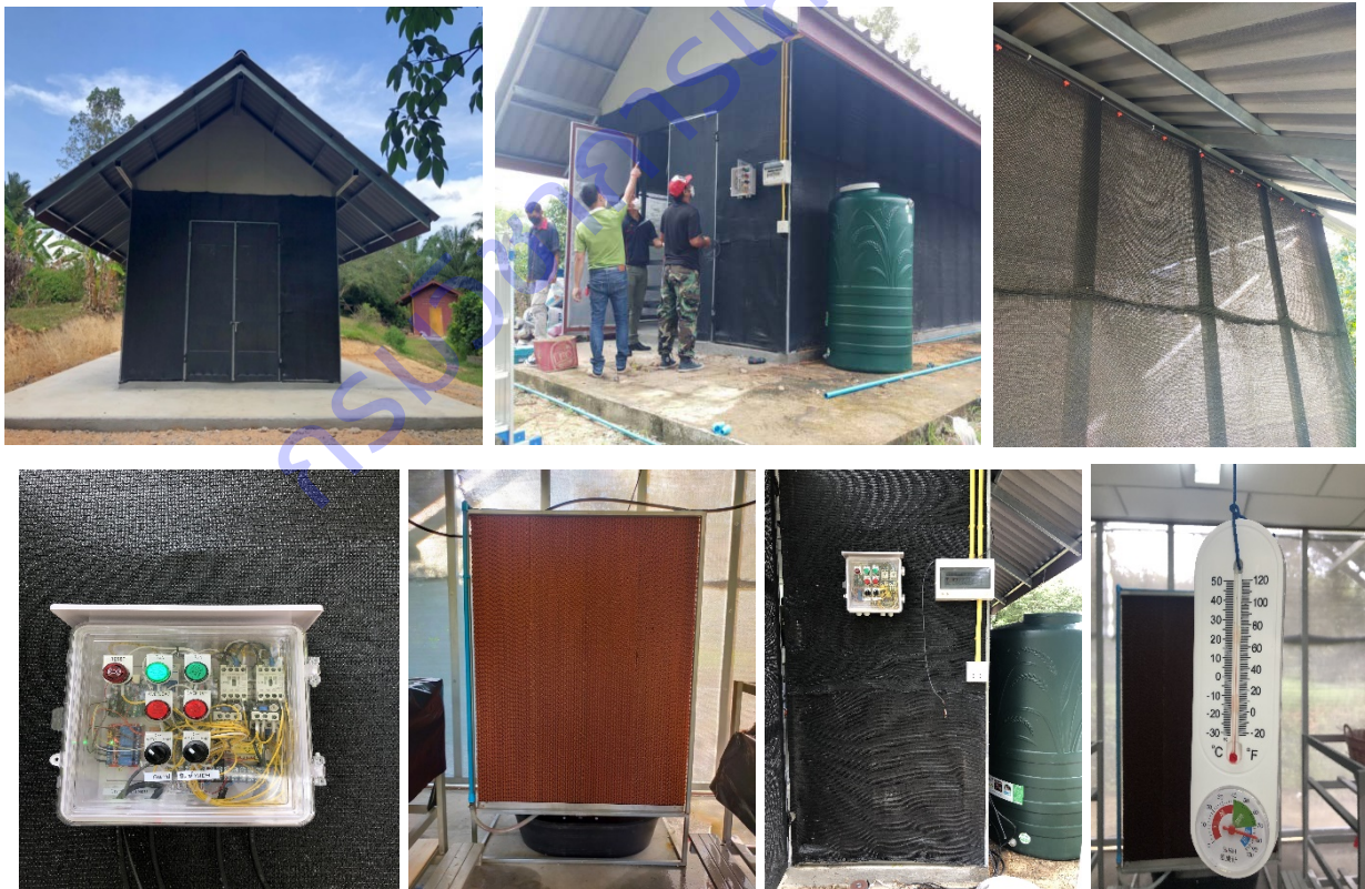
ภาพที่ 3 การก่อสร้างโรงเรือนเห็ดและติดตั้งระบบ Evaporative Cooling Systems
