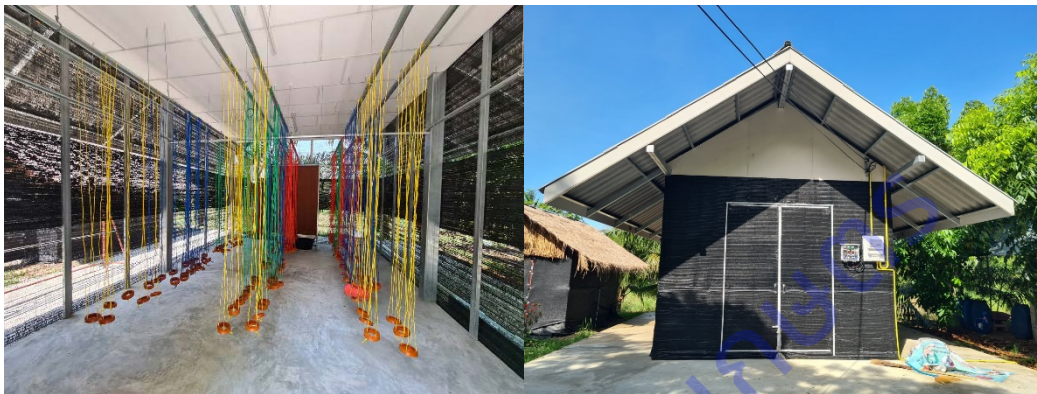
ภาพที่ 1 การก่อสร้างโรงเรือนเห็ดและติดตั้งระบบ Evaporative Cooling Systems
