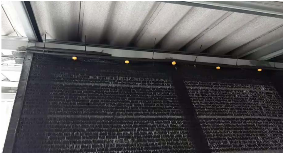
ภาพที่ 3 ระบบน้ำหยด ฝู่เหนือผนังของโรงเรียน
