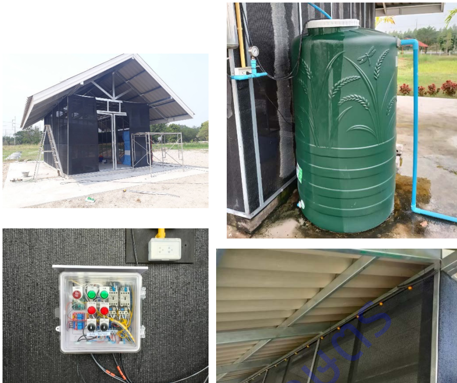
ภาพที่ 3 การก่อสร้างโรงเรือนเห็ดและติดตั้งระบบ Evaporative Cooling Systems
