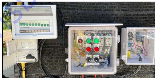
ภาพที่ 5 กล่องควบคุมอัจฉริยะสำหรับโรงเรือนเห็ด
