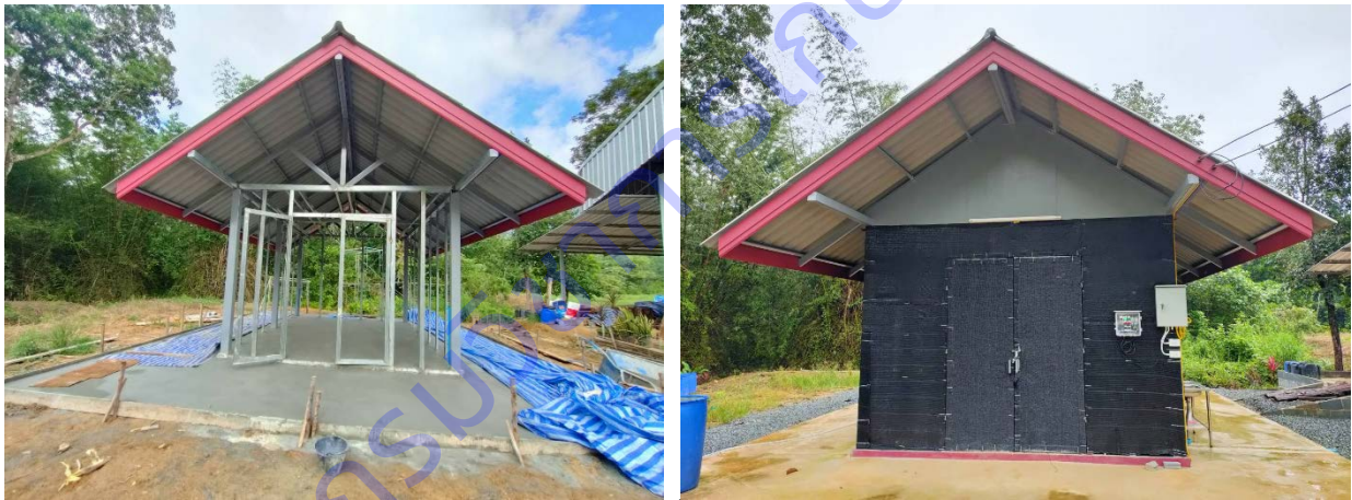
ภาพที่ 1 การก่อสร้างโรงเรือนหัตถ์และติดตั้งระบบ Evaporative Cooling Systems
