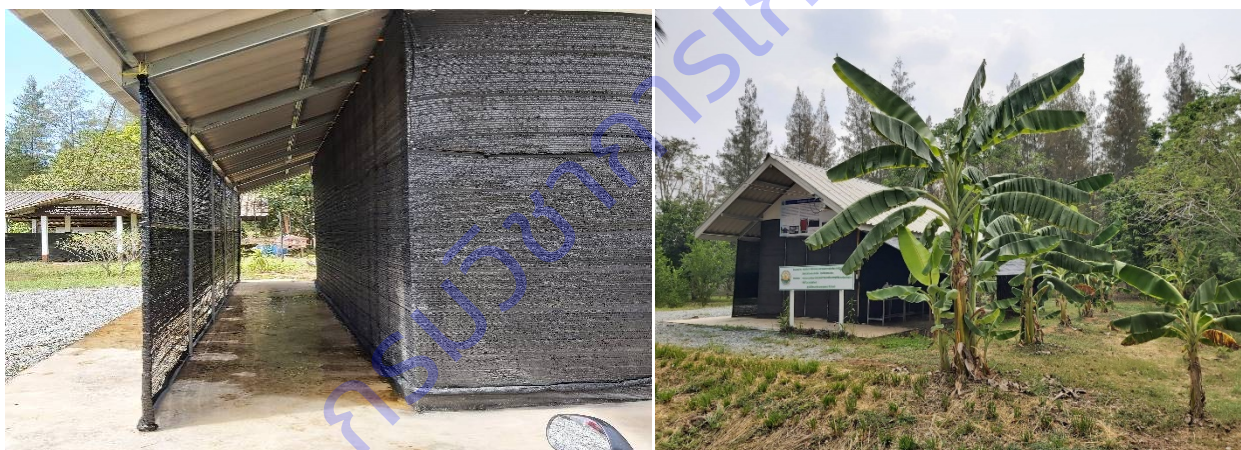
ภาพที่ 6 แสดงการติดตั้งซาแลนเพิ่มด้านข้างโรงเรือนและปลูกพืชเพื่อเพิ่มร่มเงา
