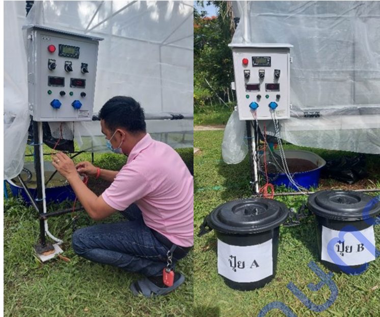
ภาพที่ 1.3 ติดตั้งอุปกรณ์ควบคุมสารละลายและทดสอบการทำงาน
