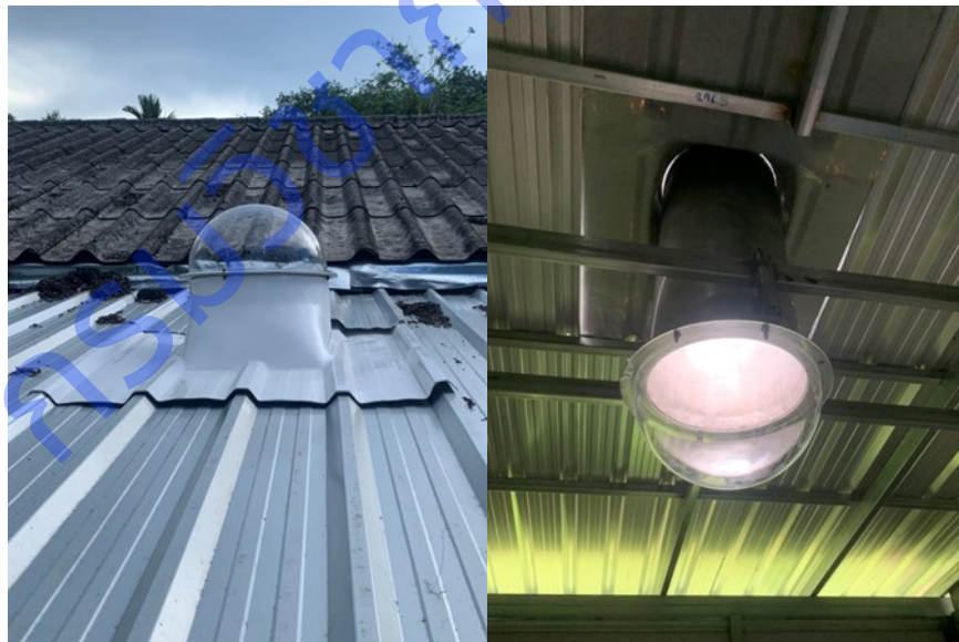
ภาพที่ 2.4 ระบบท่อนำแสงธรรมชาติสำหรับปลูกพืชในห้องทดลอง
