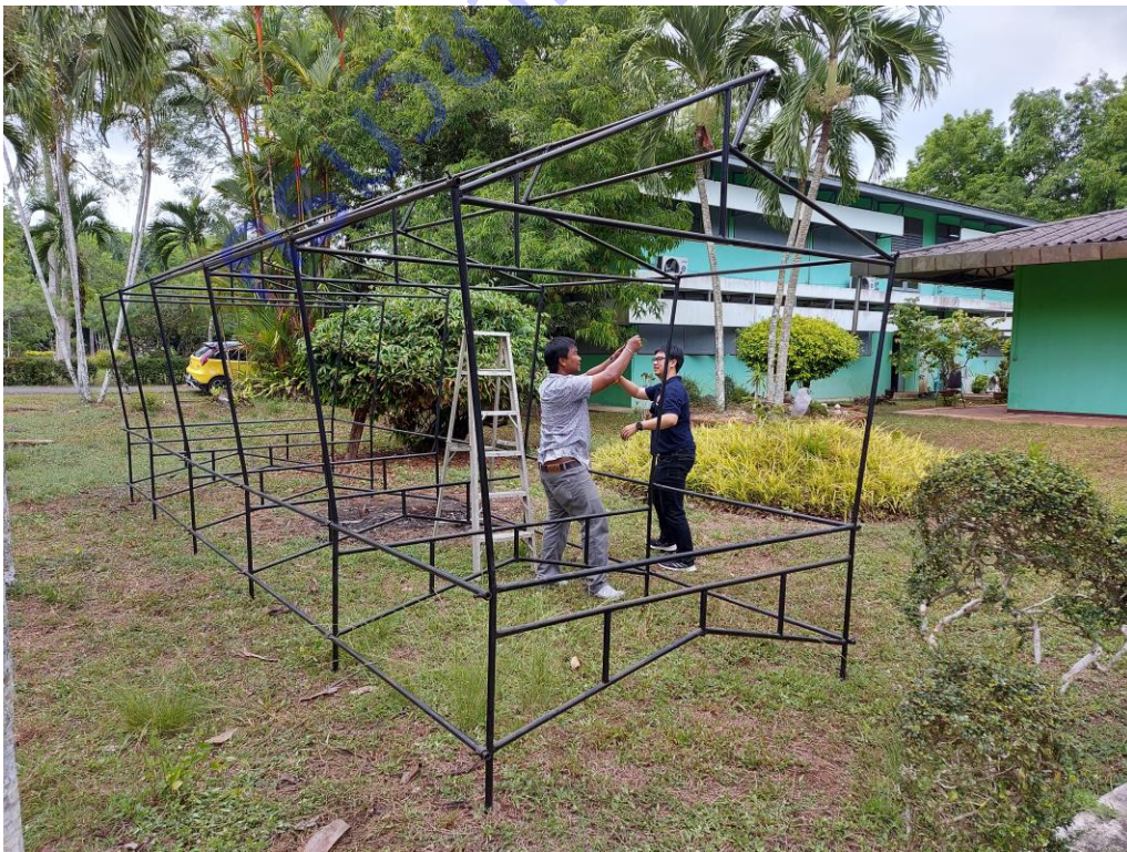
ภาพที่ 1.11 ประกอบโครงสร้างโรงเรือน
