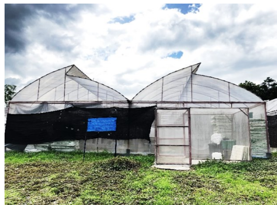
ลักษณะโครงสร้างหลังคาแบบ ก.ไก่ (พื้นเลื้อย)
