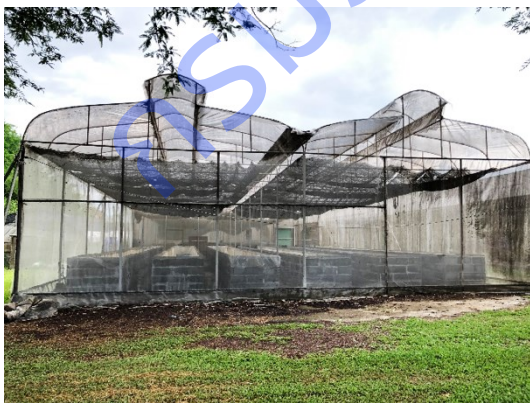
ลักษณะโครงสร้างหลังคาแบบจั่วสองชั้น
