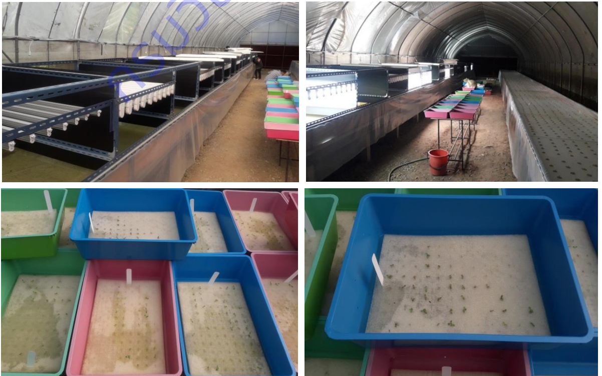
ภาพที่ 1 การติดตั้งระบบไฟฟ้าสำหรับปลูกพืชผัก
