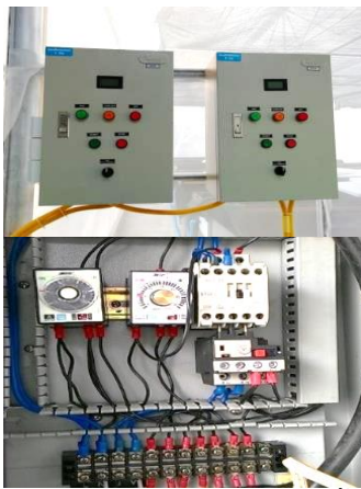
(ญ) ระบบควบคุมเวลา การให้น้ำ ให้ปุ๋ย และแสงสว่าง
