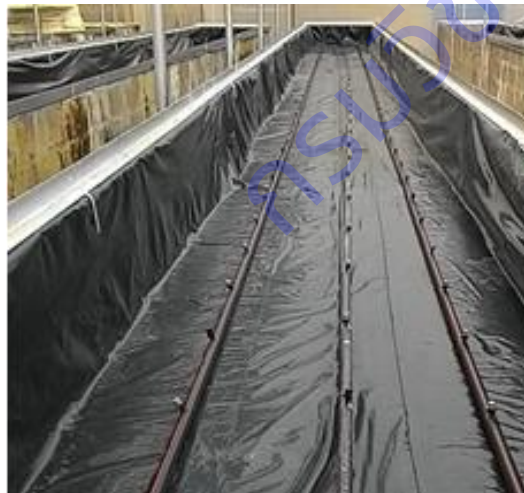
(ช) การวางท่อส่งน้ำและเจาะรูน้ำสำหรับพ่นฝอยภายในกระบะปลูก
