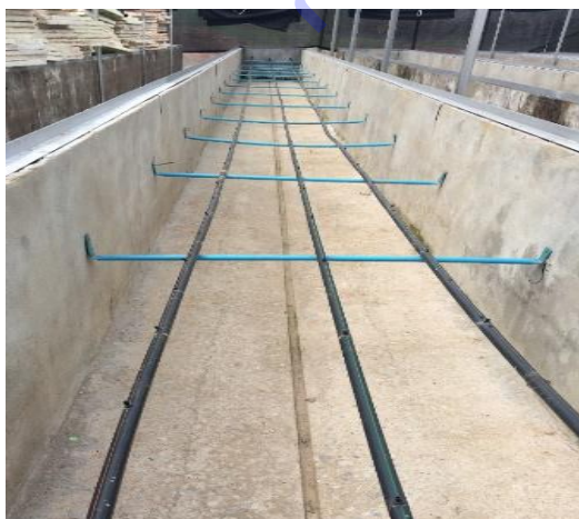
(ข) โครงสร้างกระบะปลูกแบบปูนไม่มีวัสดุรองรับ
