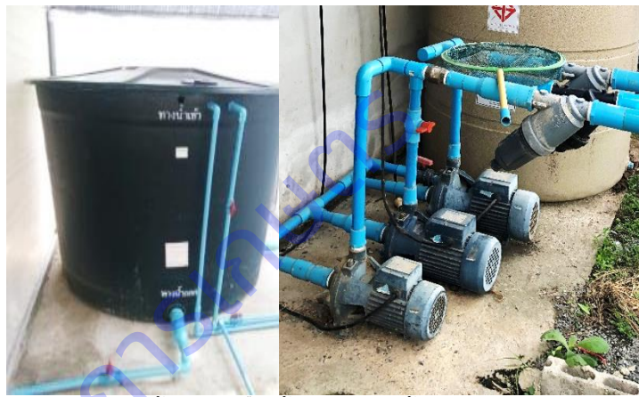
(ฐ) การติดตั้งถังและปั้มน้ำสำหรับส่งน้ำเข้ากระเพาะปลูก
