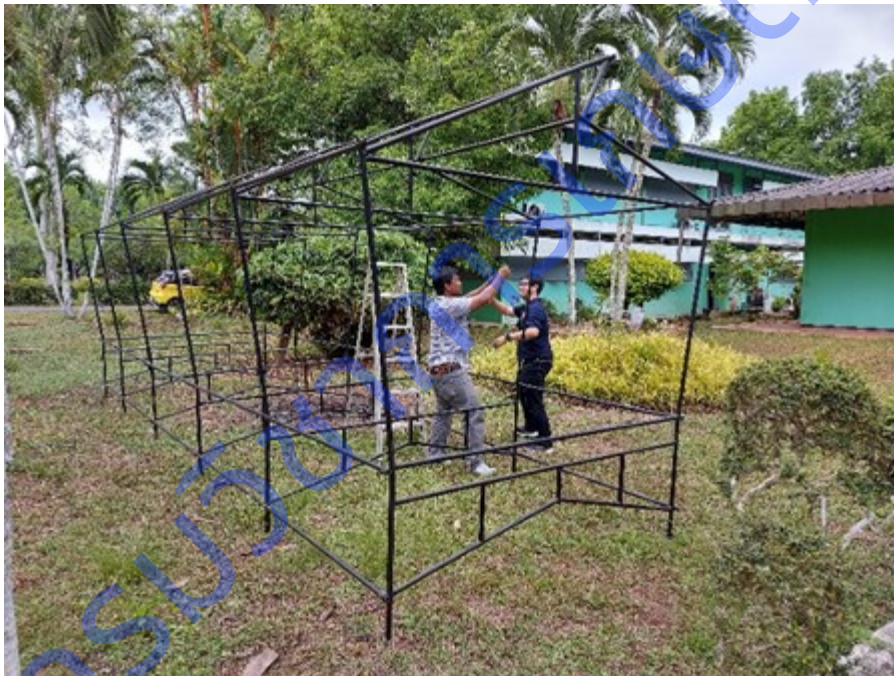
ภาพที่ 1.1 ประกอบโครงสร้างโรงเรือนต้นแบบ
