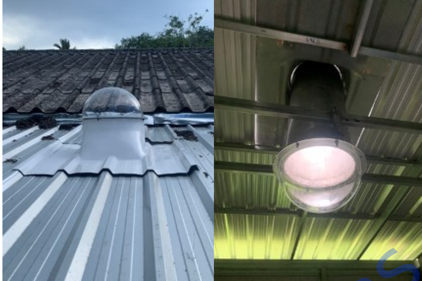
ภาพที่ 2.4 ระบบท่อนำแสงธรรมชาติสำหรับปลูกพืชในท้องทดลอง
