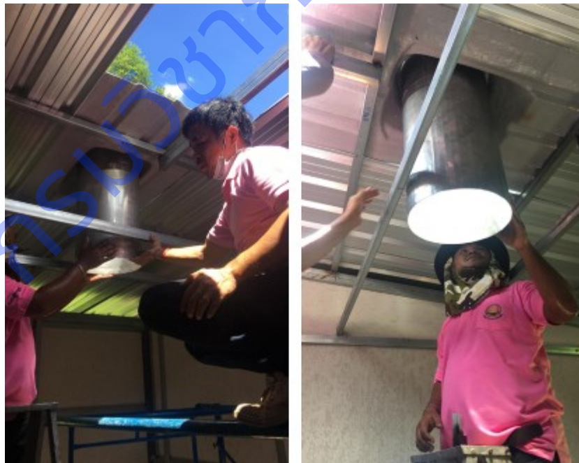
ภาพที่ 2.3 การติดตั้งท่อนำแสงผ่านหลังคาเข้าในตัวอาคารห้องทดลอง
