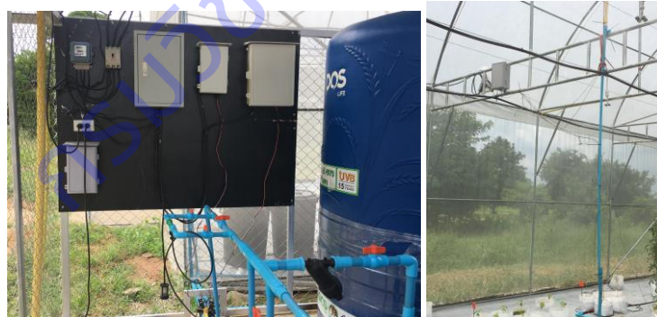
ภาพที่ 1.21 แผงชุดควบคุมระบบจ่ายน้ำมีเตอร์ไฟฟ้า และชุดเครื่องมือบันทึกสภาพแวดล้อม
