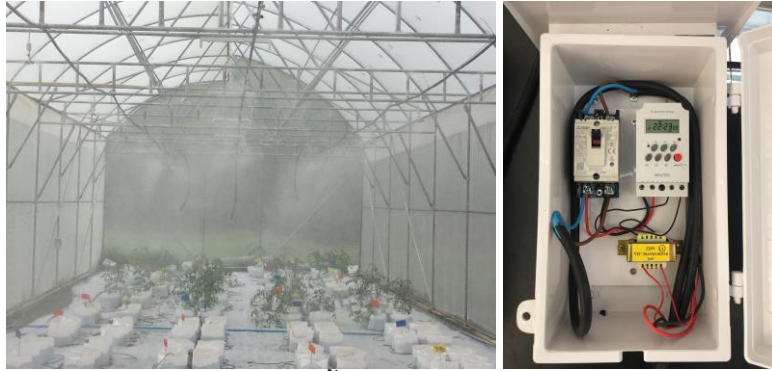
ภาพที่ 1.19 ระบบควบคุมการให้น้ำแบบพ่นหมอกเพื่อช่วยลดอุณหภูมิในโรงเรือน
