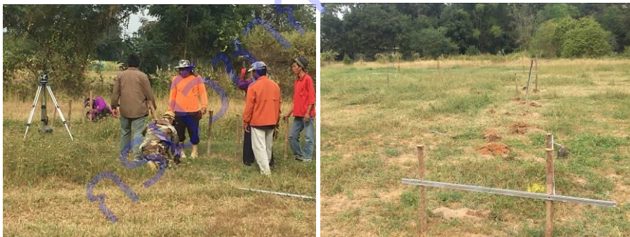
ภาพที่ 1.8 สำรวจและวัดระดับเพื่อปรับพื้นที่และวางผังการจัดสร้างโรงเรือน
