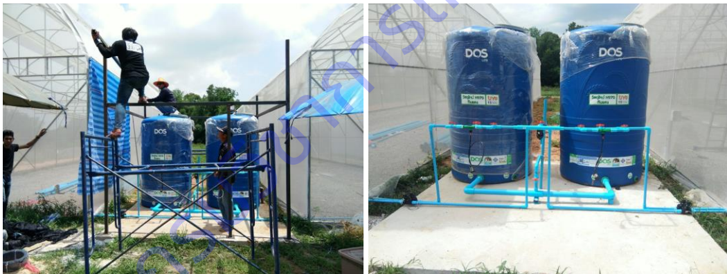
ภาพที่ 1.14 การติดตั้งระบบการจ่ายปุ๋ยทางน้ำ และโรงปื้มน้ำสำหรับโรงเรือนทั้ง 2 แบบ
