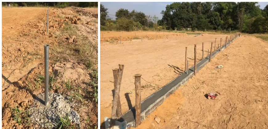
ภาพที่ 1.8 สำรวจและวัดระดับเพื่อปรับพื้นที่และวางผังการจัดสร้างโรงเรือน
