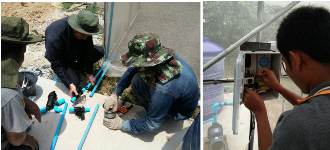
ภาพที่ 1.14 การติดตั้งระบบการจ่ายปุ๋ยทางน้ำ และโรงปื้มน้ำสำหรับโรงเรือนทั้ง 2 แบบ
