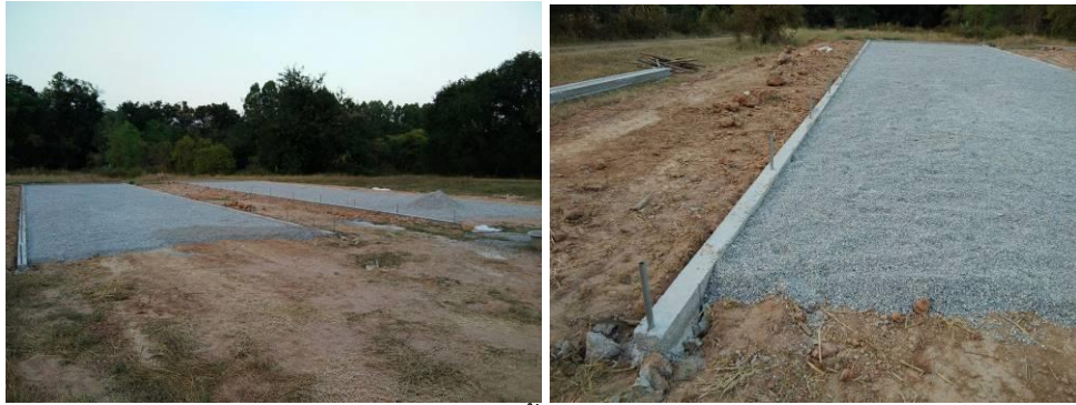
ภาพที่ 1.10 ปรับระดับพื้นโรงเรือนด้วยหินเบอร์ 3/4
