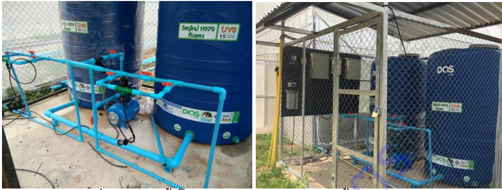
ภาพที่ 1.16 ติดตั้งปั้มน้ำและระบบควบคุมการจ่ายน้ำภายในโรงเรือน
