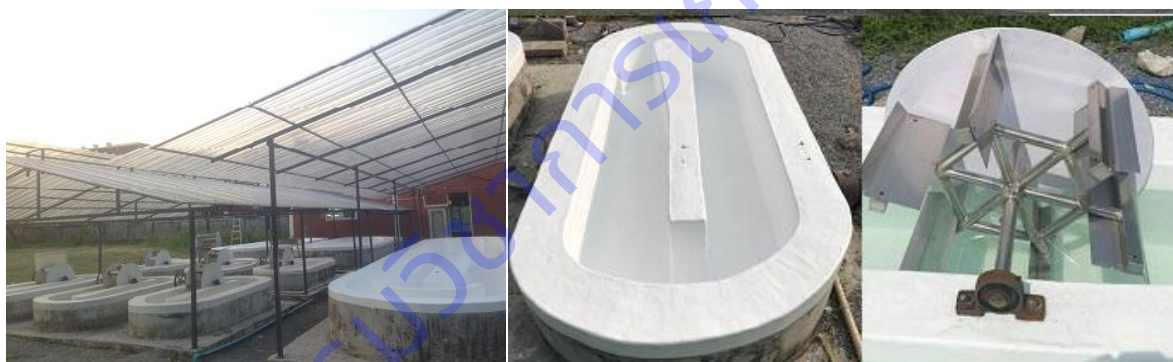
ภาพที่ 13 การเคลือบผิวบ่อเพาะเลี้ยงสาหร่ายด้วยไฟเบอร์กลาสแผ่นโปร่งแสงป้องกันน้ำฝน
