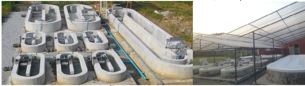
ภาพที่ 1 บ่อเพาะเลี้ยงสาหร่ายแบบเปิด (Raceway open pond)
