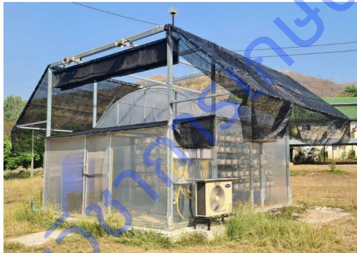
รูปที่ 19 ติดตั้งแสดนพรางแสงด้านข้าง
