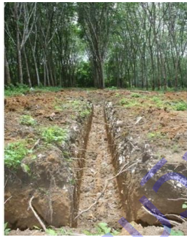
ภาพที่ 5 การขุดร่อง กว้าง 30 เซนติเมตร ลึก 60 เซนติเมตร
