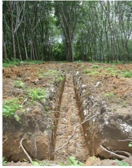
ภาพที่ 2 การขุดร่อง กว้าง 30 เซนติเมตร ลึก 60 เซนติเมตร
