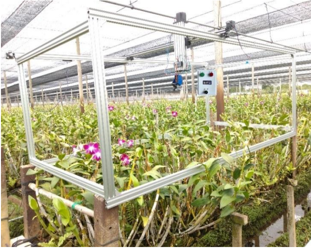
ภาพที่ 3.4 ระบบตรวจสอบเพลิงไฟ และบักกล้วยไม้ ที่ติดตั้งในโรงเรือน
