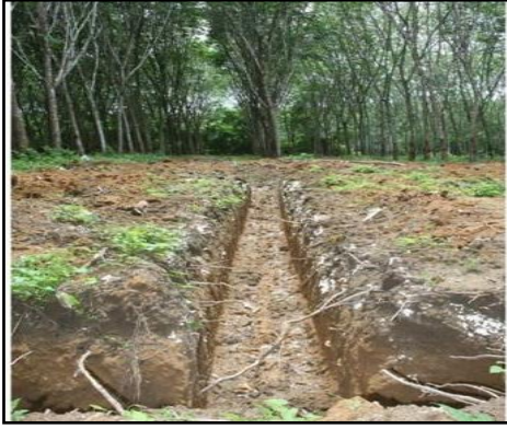
ภาพที่ 2 การขุดร่อง กว้าง 30 เซนติเมตร ลึก 60 เซนติเมตร
