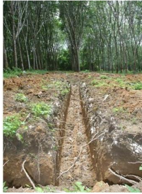
ภาพที่ 2 การขุดร่อง กว้าง 30 เซนติเมตร ลึก 60 เซนติเมตร
