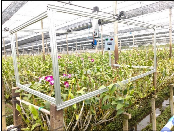
ภาพที่ 1 ระบบตรวจสอบเพลิงไฟ และบัวกล้วยไม้ที่ติดตั้งในโรงเรือน
