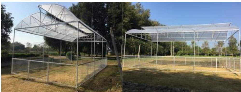
ภาพที่ 7 โรงเรือนหลังคาโค้งเหลื่อมมุงพลาสติกขนาด 150 ไมครอน
