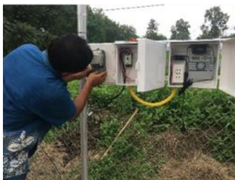
ภาพที่ 8 ติดตั้งระบบควบคุมไฟฟ้าแสงสว่างในโรงเรือน
