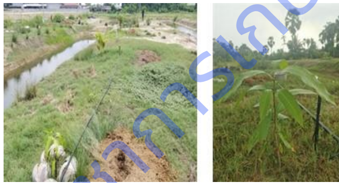
ภาพที่ 38 การเตรียมและติดตั้งระบบน้ำแปลงมะม่วง
