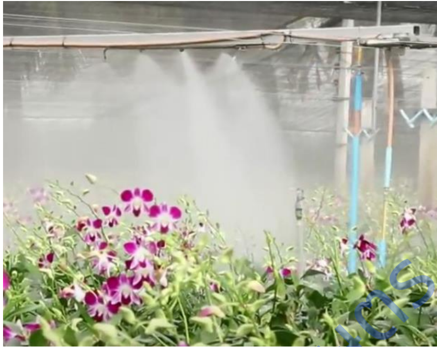
ภาพที่ 10 ระบบพ่นสารเคมีแบบแปรผันอัตราได้ที่ติดตั้งในโรงเรือน
