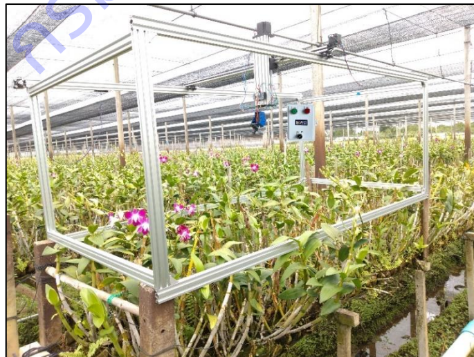
ภาพที่ 2 ระบบตรวจสอบเพลิงไฟ และบั่วกล้วยไม้ที่ติดตั้งในโรงเรือน
