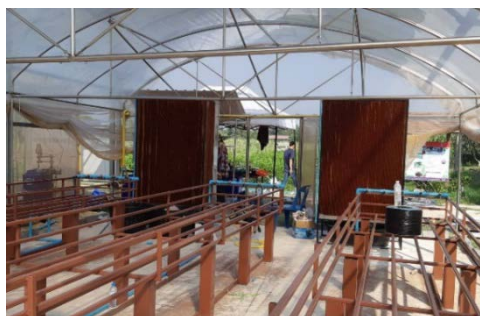
ภาพที่ 9 ติดตั้งโครงสร้างสำหรับตาข่ายพรางแสง และติดตั้งเครื่องทำความชื้น
