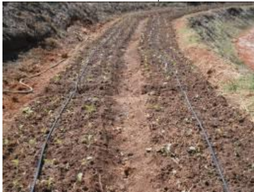
(ค) ติดตั้งระบบน้ำหยด
