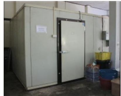
ห้องควบคุมอุณหภูมิ
