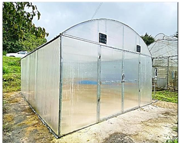
โรงอบแห้งกาแฟกะลาอะราบิก้าด้วยพลังงานแสงอาทิตย์
