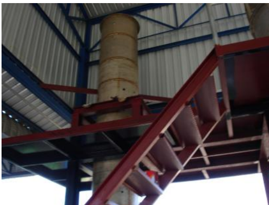
ภาพที่ 4 การก่อสร้างโครงสร้าง (Platform) และการจัดวางชุดผลิตไบโอดีเซลเข้ากับโครงสร้างพร้อมบันไดภายในโรงผลิตไบโอดีเซล
