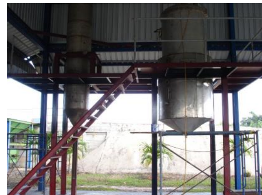
ภาพที่ 4 การก่อสร้างโครงสร้าง (Platform) และการจัดวางชุดผลิตไบโอดีเซลเข้ากับโครงสร้างพร้อมบันไดภายในโรงผลิตไบโอดีเซล
