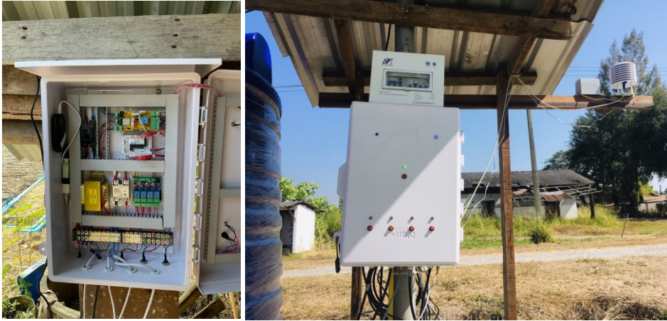
รูปที่ 8 กล่องควบคุมระบบจ่ายน้ำอัตโนมัติ (IoT) ตามความต้องการน้ำของถั่วเหลือง
