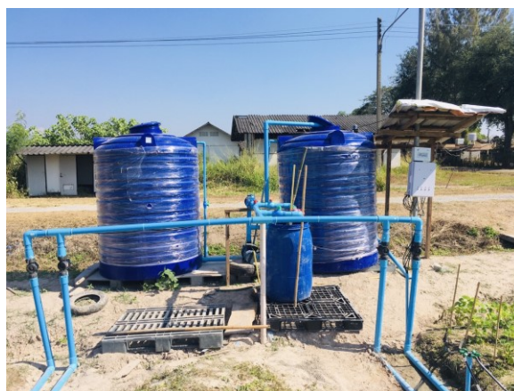
รูปที่ 7 ระบบจ่ายน้ำอัตโนมัติ (IoT) ที่ใช้ในแปลงถั่วเหลือง
