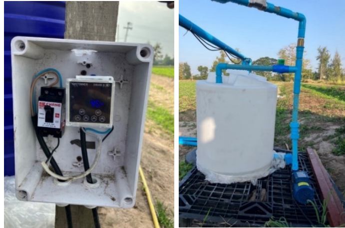
รูปที่ 10 ระบบควบคุมการให้ปุ๋ยแบบอัตโนมัติและถังใส่ปุ๋ย
