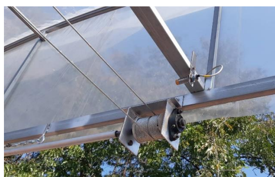
รูป มอเตอร์ขับเคลื่อนพรางแสง ทำงานอัตโนมัติเมื่ออุณหภูมิสูงกว่า 30 องศาเซลเซียส และตัดอัตโนมัติเมื่อตาข่ายพรางแสงเลื่อนสุดถึงเซนเซอร์จับโลหะ
